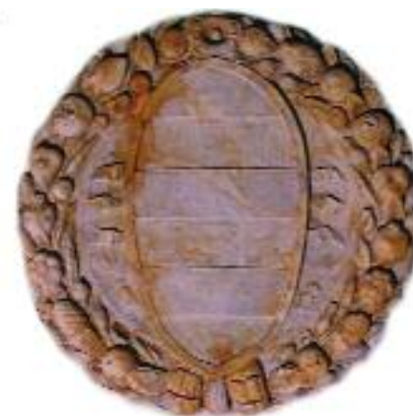
Figure 5 e 6. Roma, vicolo Savelli, palazzetto Carafa. I capitelli marmorei del portico (inizio XVI secolo), che al centro della crociera centrale reca lo stemma Carafa, lesionati a seguito dell'opera di addossamento di pilastri in conglomerato cementizio armato e offuscati da incrostazioni per gli usi impropri del locale come officina, sono stati liberati e puliti con il metodo JOS, lo stesso impiegato per la pulitura della facciata della basilica di San Pietro, conclusa nel settembre 1999.
