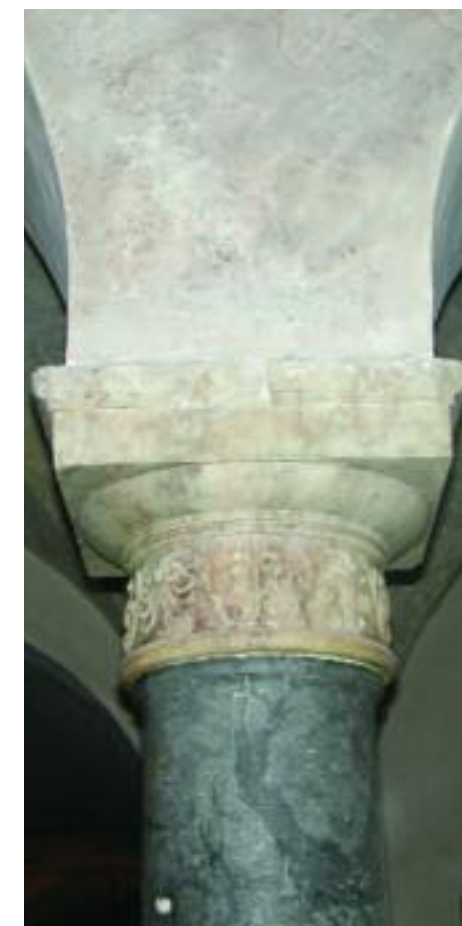
Figure 5 e 6. Roma, vicolo Savelli, palazzetto Carafa. I capitelli marmorei del portico (inizio XVI secolo), che al centro della crociera centrale reca lo stemma Carafa, lesionati a seguito dell'opera di addossamento di pilastri in conglomerato cementizio armato e offuscati da incrostazioni per gli usi impropri del locale come officina, sono stati liberati e puliti con il metodo JOS, lo stesso impiegato per la pulitura della facciata della basilica di San Pietro, conclusa nel settembre 1999.
