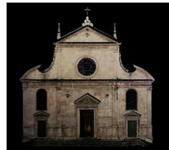
Figure 2-3. Facciata di Santa Maria del Popolo: in alto, proiezione ortometrica in visualizzazione grayscale ; in basso, in mesh e visualizzazione true color da nuvole di punti tridimensionali.
