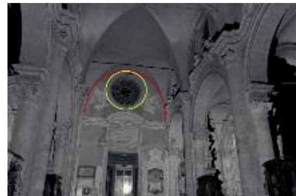
Figura 18. Posizione dell'oculo all'interno della chiesa di Santa Maria del Popolo, tangente al colmo della volta, nel modello tridimensionale.
