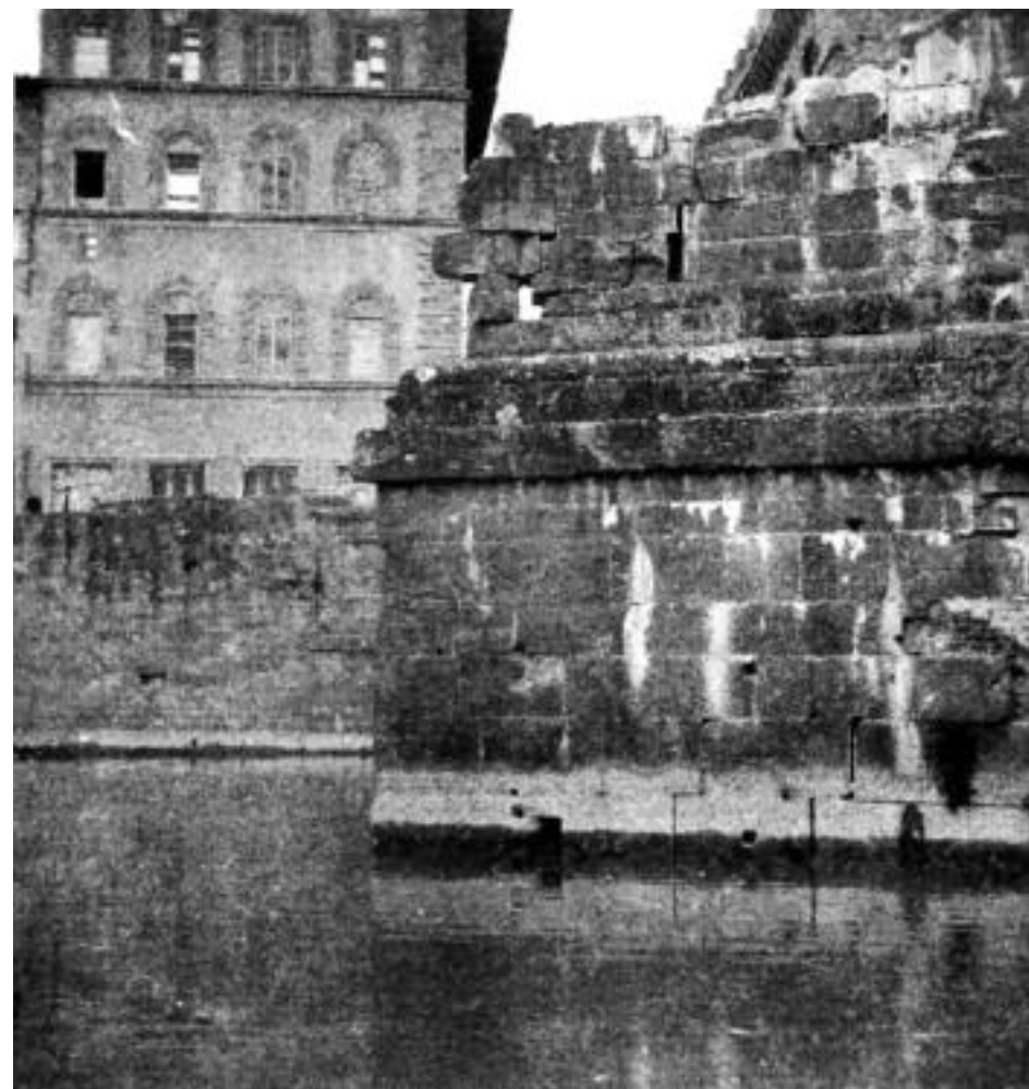
Figura 17. Il paramento lapideo di un rostro del ponte a Santa Trinita dopo le esplosioni del 1944 (Gabinetto fotografico della Soprintendenza speciale per il Polo museale fiorentino).
