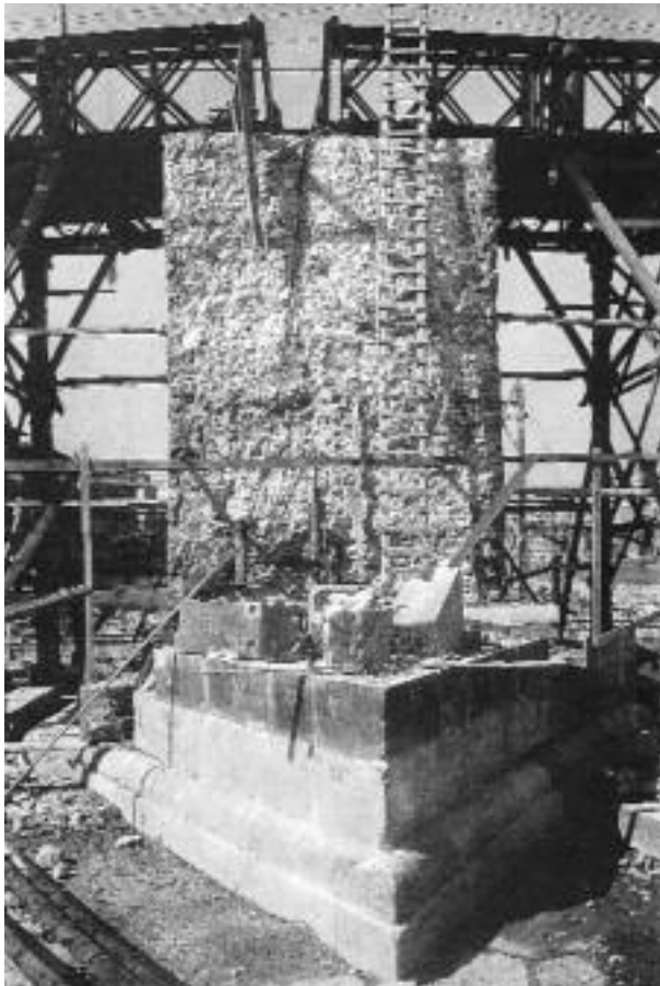
Figura 18. Il nucleo in calcestruzzo di una pila del ponte a Santa Trinita nel 1955, da P. Paoletti, Il ponte a Santa Trinita com'era e dov'era . Dalla distruzione del 1944 al ritrovamento della testa della Primavera nel 1961, Firenze 1987.
