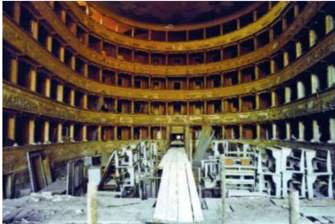
Figura 16. Senigallia, il teatro comunale La Fenice prima della demolizione.
